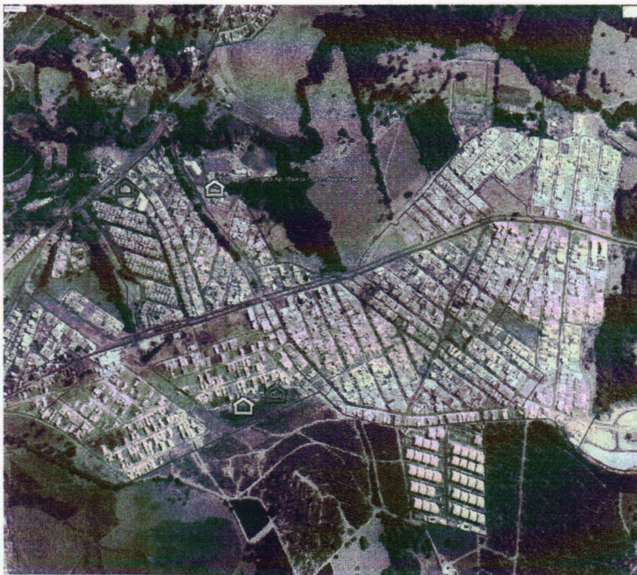
Imagem 2 – Local da construção da nova Escola Municipal e CEMEI que atenderão os bairros Santa Luzia, Sagrado Coração I e II e bairros adjacentes.
