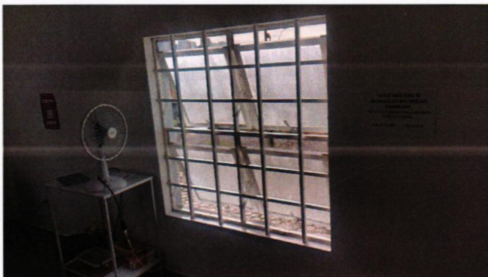
Falta de toldo nas janelas, fazendo ficar muito quente em dias de sol e em dias chuvosos a água acaba entrando pela janela e alaga a sala
