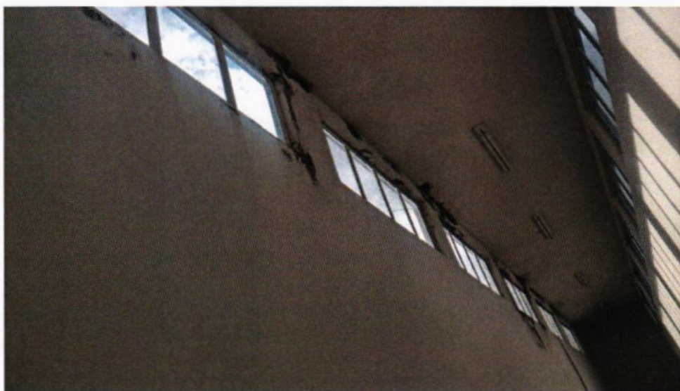
Falta de toldo nas janelas, fazendo ficar muito quente em dias de sol e em dias chuvosos a água acaba entrando pela janela e alaga a sala
