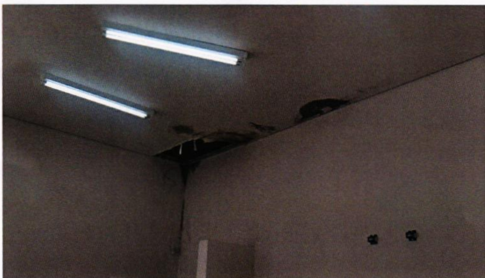
Mofo se alastrando devido à falta de ventilação
