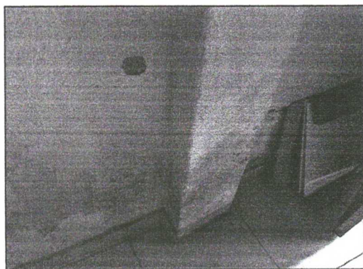
Indícios de infiltrações paredes
