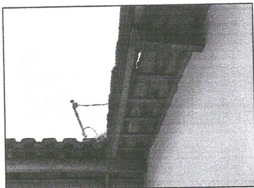
Telha quebrada no beiral
