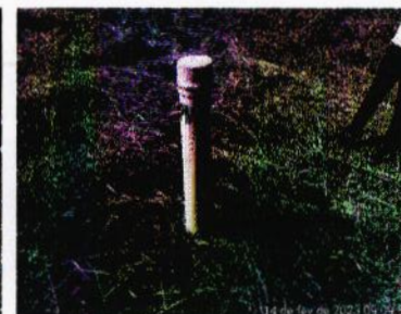
Imagem 10: Poço para monitoramento de águas subterrâneas – Aterro Sanitário de Varginha/MG.
